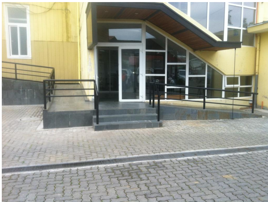
Mejoramiento Acceso Edificio Municipal
