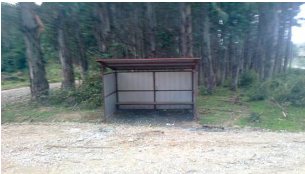
Reposición Garitas Diversos Sectores Rurales
